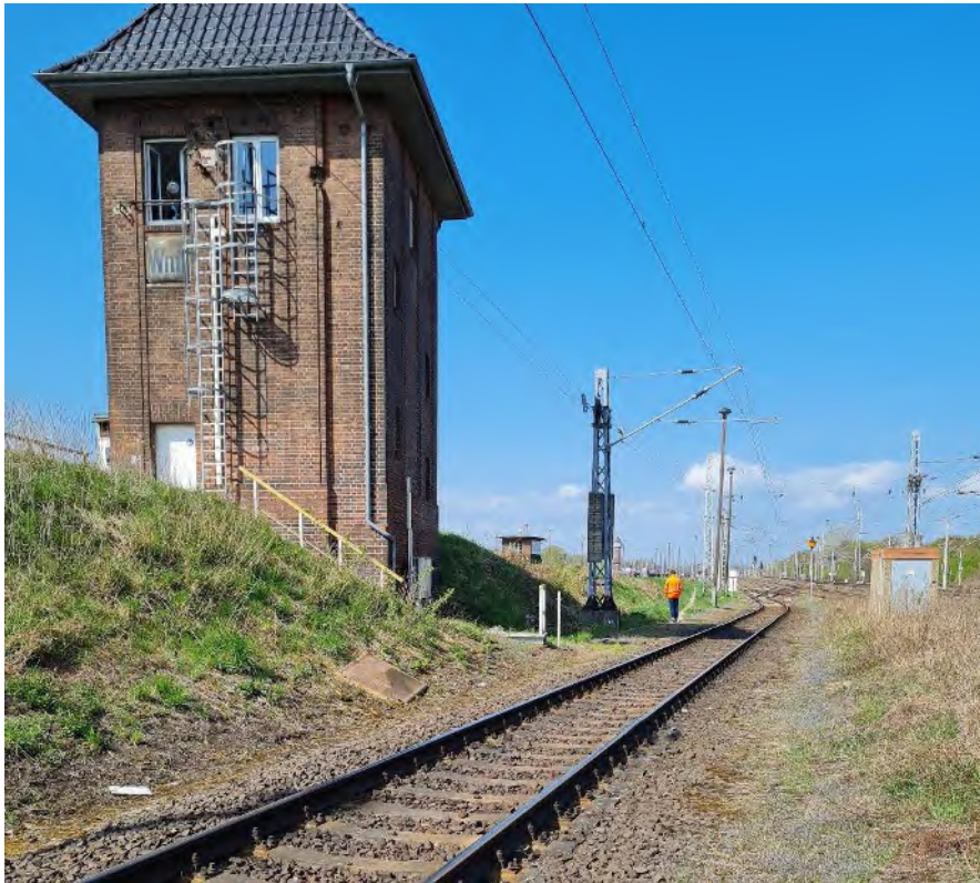
Abb. 9: Stellwerk Wmt im Bereich Gleis 28– Blickrichtung Südwesten
