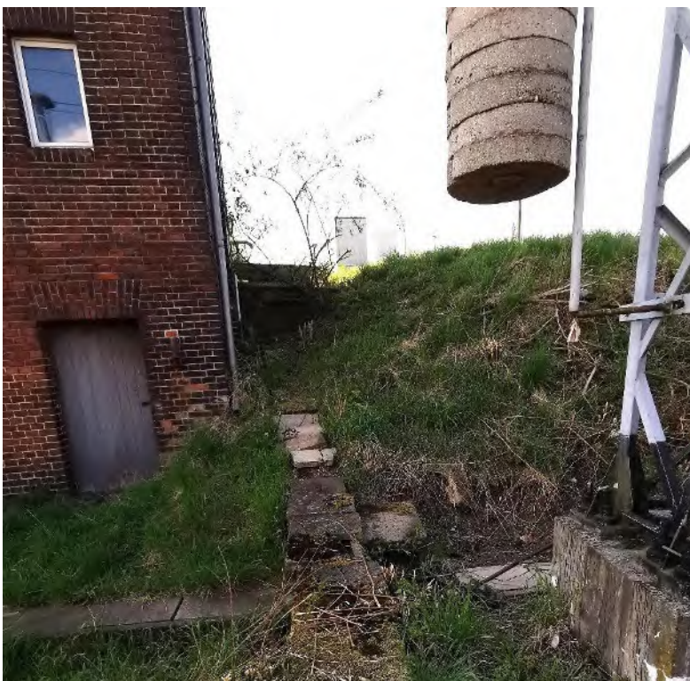
Abb. 10: Kellereingang Stellwerk Wmt – Blickrichtung Süden von Gleis 28
