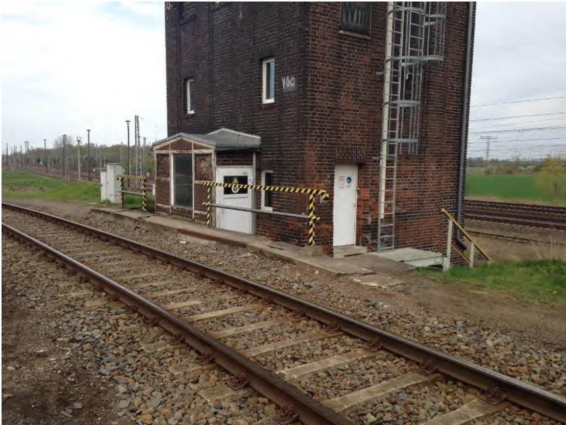
Abb. 7: Stellwerk Wmt im Bereich Gleis 26 – Blickrichtung Nordwesten
