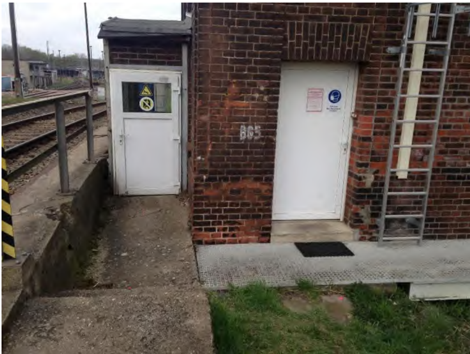
Abb. 8: Eingangsbereich Stellwerk Wmt – Blickrichtung Westen
