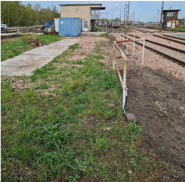
Abb. 6: Bereich zukünftige Zuwegung Stw Wmt – Blickrichtung Westen, Richtung Innerbetrieblichem Bahnübergang
