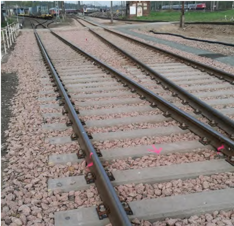
Abb. 5: Endteil Weiche 64 – Blickrichtung Westen, Richtung Innerbetrieblicher BÜ
