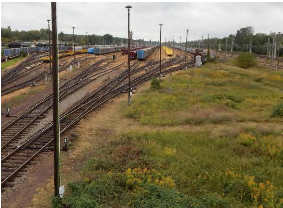
Abb. 16: im Vordergrund Gleisharfe von Weiche 91 in Gleise 67 bis 59 einschl. Verlänge- rungsbereich für Gleise 65 bis 59 – Blickrichtung Westen vom RS III
