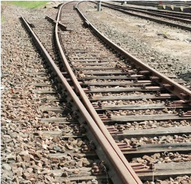
Abb. 17: Weichenrest Weiche 97 im Gleise 59 – Blickrichtung Osten
