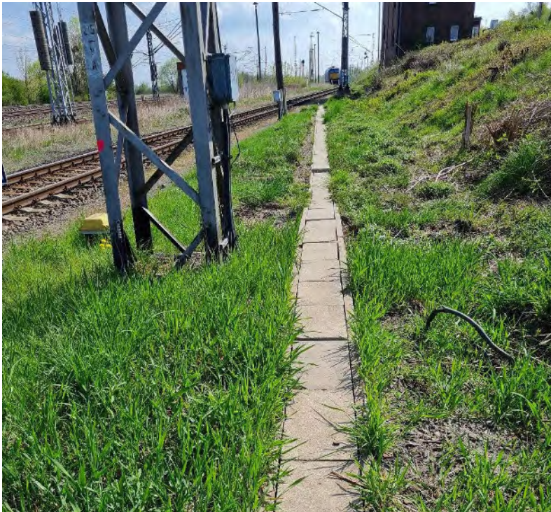
Abb. 11: bauzeitl. Zuwegung in Baustufe 1 zum Stellwerk Wmt entlang Gleis 28 – Blickrichtung Osten
