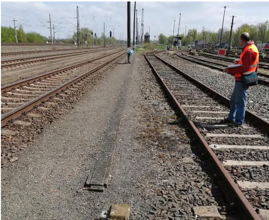
Abb. 18: Umbauende Oberbauwechsel in Gleise 59 – Blickrichtung Osten
