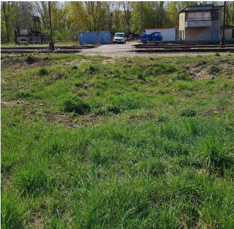
Abb. 12: bauzeitl. Zuwegung in Baustufe 1 zum Stellwerk Wmt von Gleis 28 Richtung Innerbetrieblicher BÜ – Blickrichtung Osten
