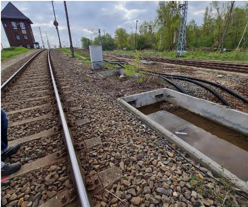
Abb. 13: Gleis 26 mit Resten alte Gleisbremse neben Gleis – Blickrichtung Osten
