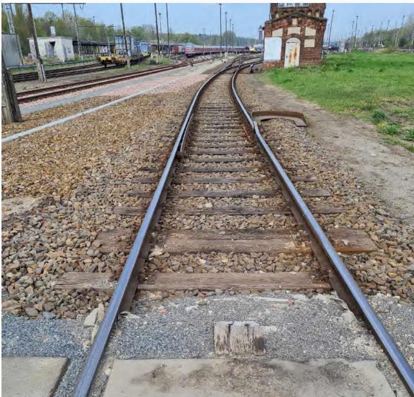
Abb. 14: Gleis 26 zwischen Innerbetrieblichem BÜ und Weiche 72– Blickrichtung Westen
