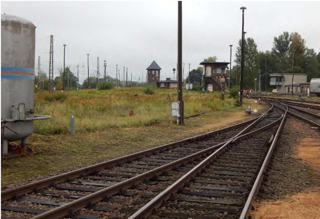
Abb. 15: Fläche für Verlängerung der Gleise 59 bis 65 – Blickrichtung Osten, vom Weichenendteil W98 Richtung Stellwerk Wmt
