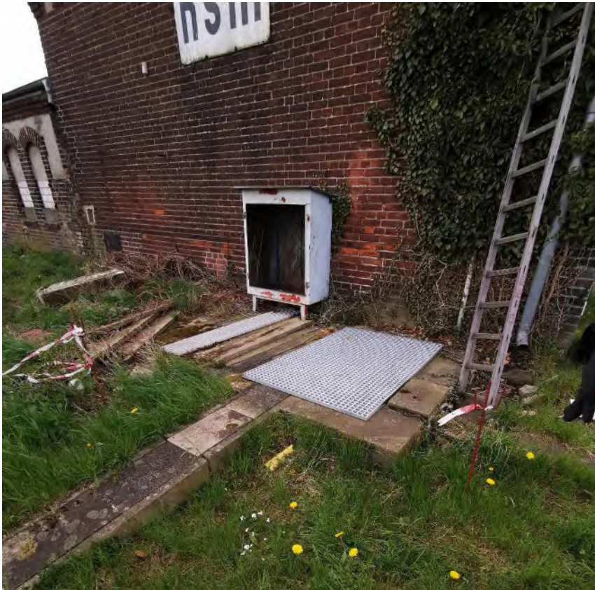
Abb. 17: Schacht am RS III – Blickrichtung Süden
