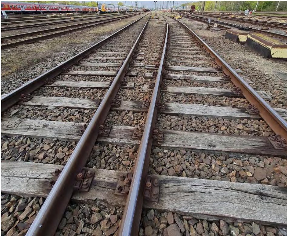
Abb. 25: Umbauende Gleise 66 = Lückenschluss Weiche 108 – Blickrichtung Westen
