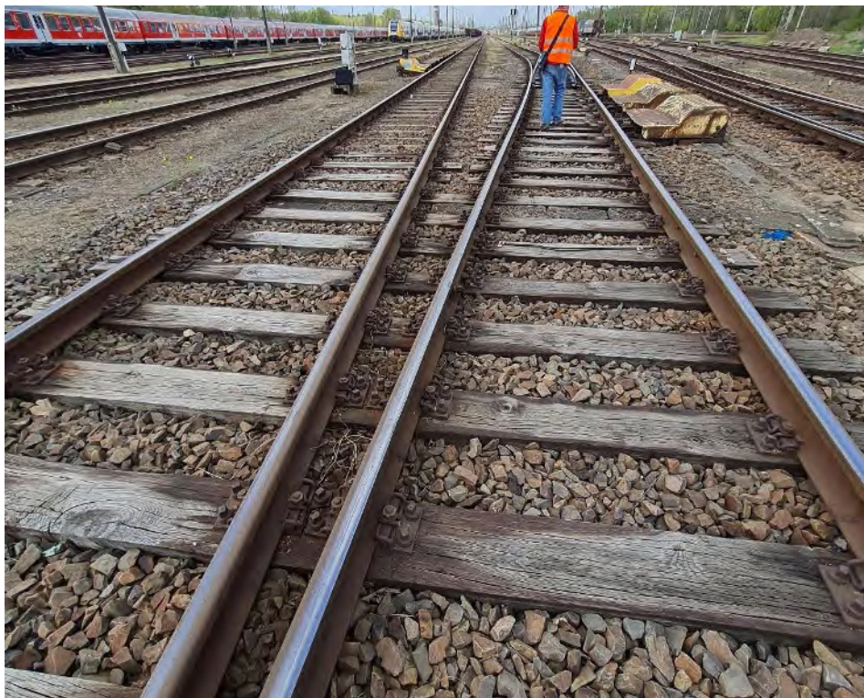
Abb. 26: Umbauende Gleise 67 = Lückenschluss Weiche 111 – Blickrichtung Westen
