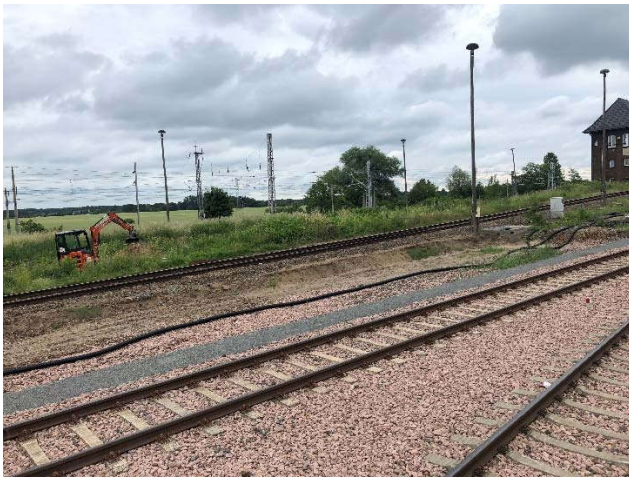
Baggerschurf 1 bis etwa 1,90 m u. GOK
