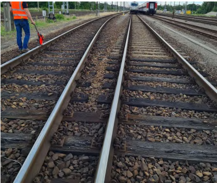
Abb. 4: Endteil Weiche 51 (links Gleis 7, rechts Gleis 8) – Blickrichtung Osten
