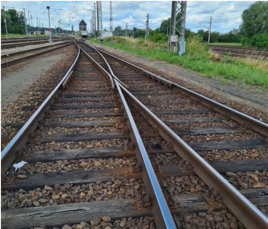
Abb. 3: Weiche 51– Blickrichtung Westen, Richtung Stw Wmt
