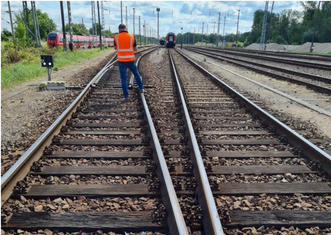
Abb. 7: Endteil Weiche 52 (links Verb. zu W51, rechts Gleis 9) – Blickrichtung Osten
