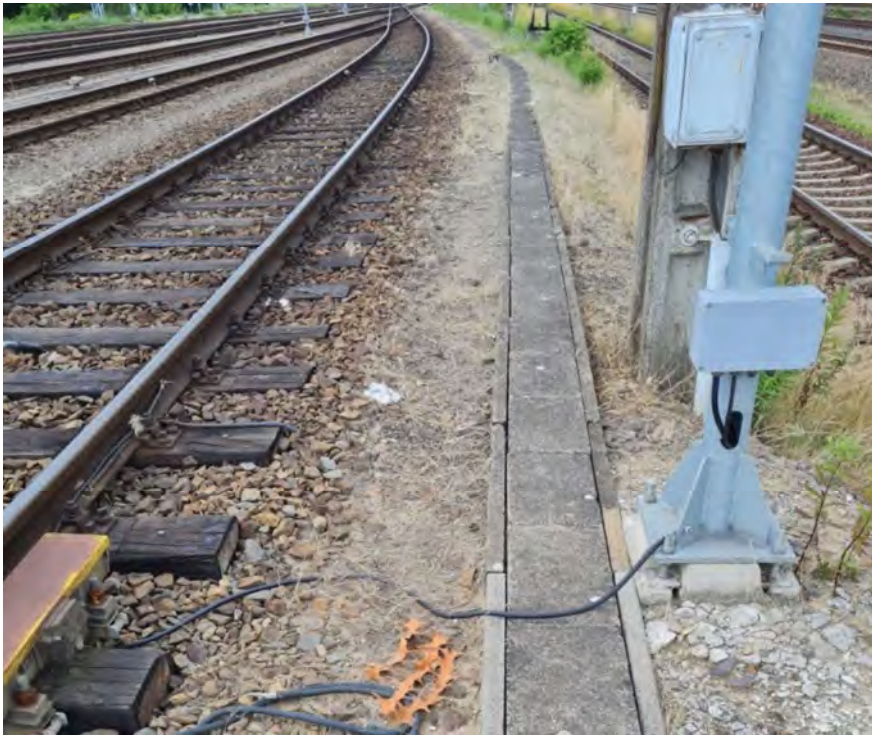
Abb. 5: Gleis 7 – Blickrichtung Westen, von Gleis 7 Richtung Weichenende W51
