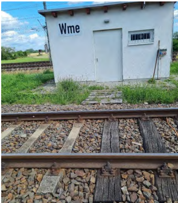
Abb. 10: Zugang ESTW-Gebäude Wme vom Stumpfgleis 9a – Blickrichtung Norden
