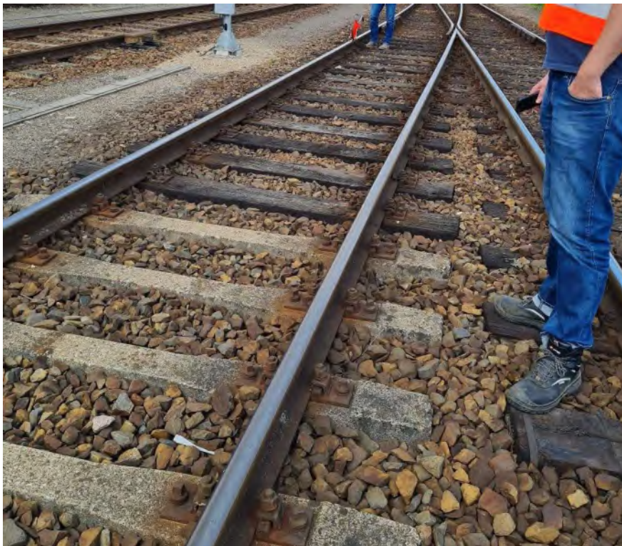
Abb. 6: Gleis 8 – Blickrichtung Westen, von Gleis 8 Richtung Weichenende W51
