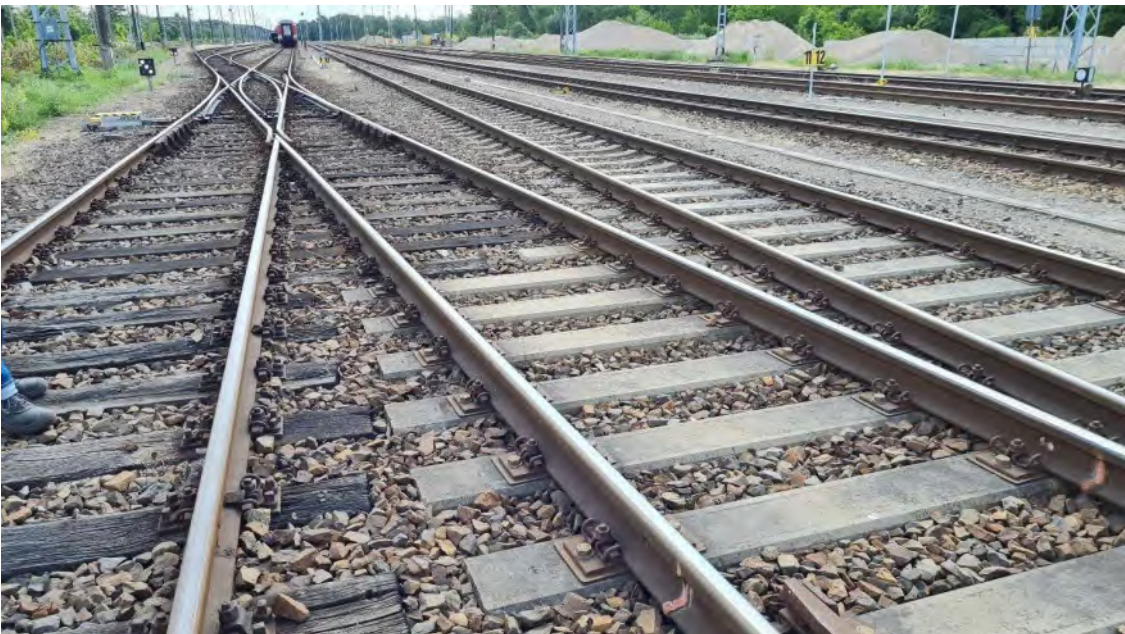
Abb. 8: Weiche 52 – Endteil (links Stumpfgleis 9a – rechts Verb. zu W53) Blickrichtung Osten
