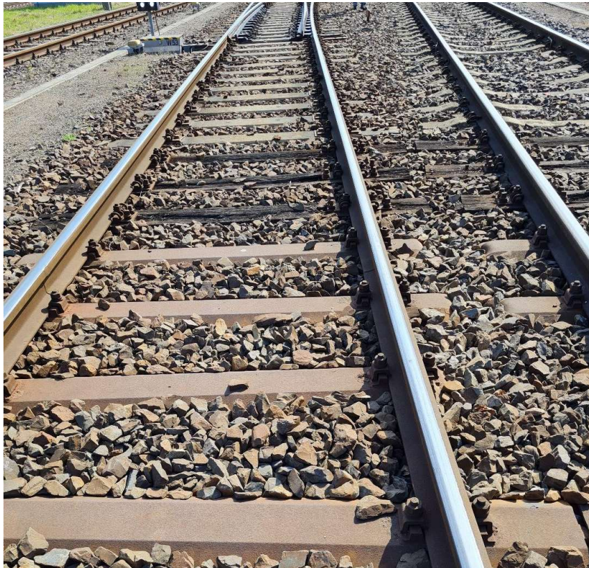
Abb. 2: Endteil Weiche 57 (links Vbg W57 – W53, rechts Gleis 11) – Blickrichtung Osten
