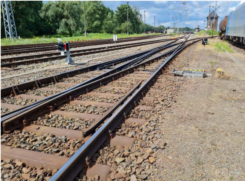
Abb. 3: Weiche 57– Blickrichtung Westen, Richtung W58, Gleis 28 und Stw Wmt
