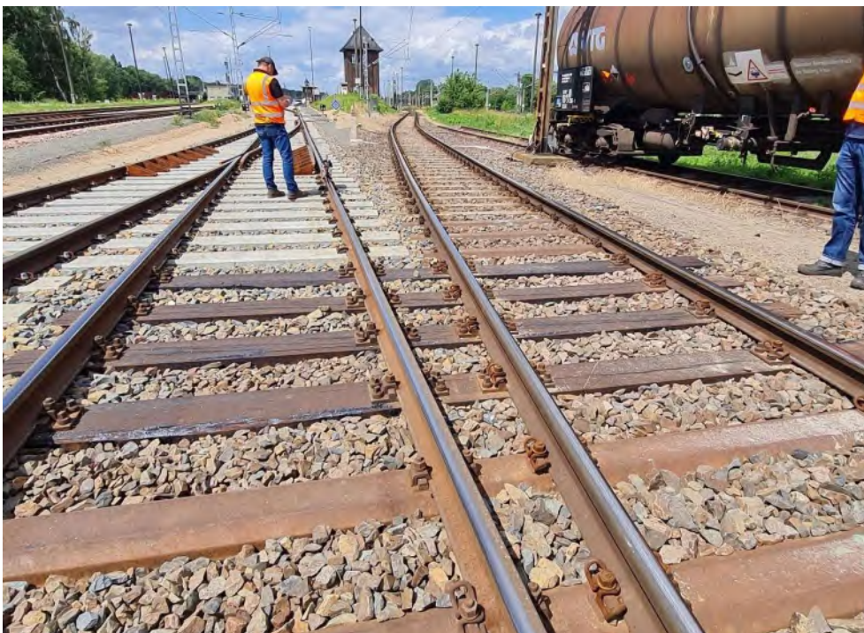
Abb. 4: Endteil Weiche 57 (links Vbg W57 – W58, rechts Gleis 28) – Blickrichtung Westen
