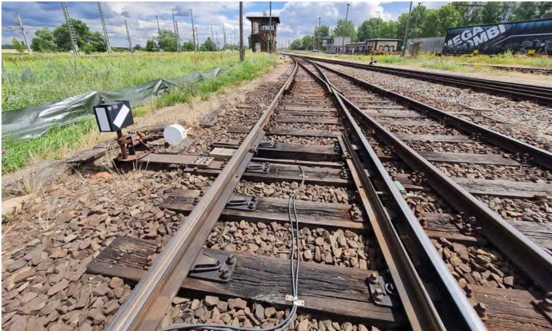
Abb. 5: Weiche 91 – Blickrichtung Osten vom Weichenanfang W110 Richtung RS III
