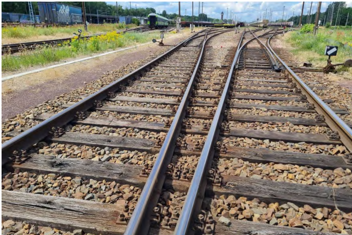
Abb. 4: Endteil Weiche 72 (zukünftig Weiche 90) (links Verb. zu W92, rechts zu W91) – Blickrichtung Westen
