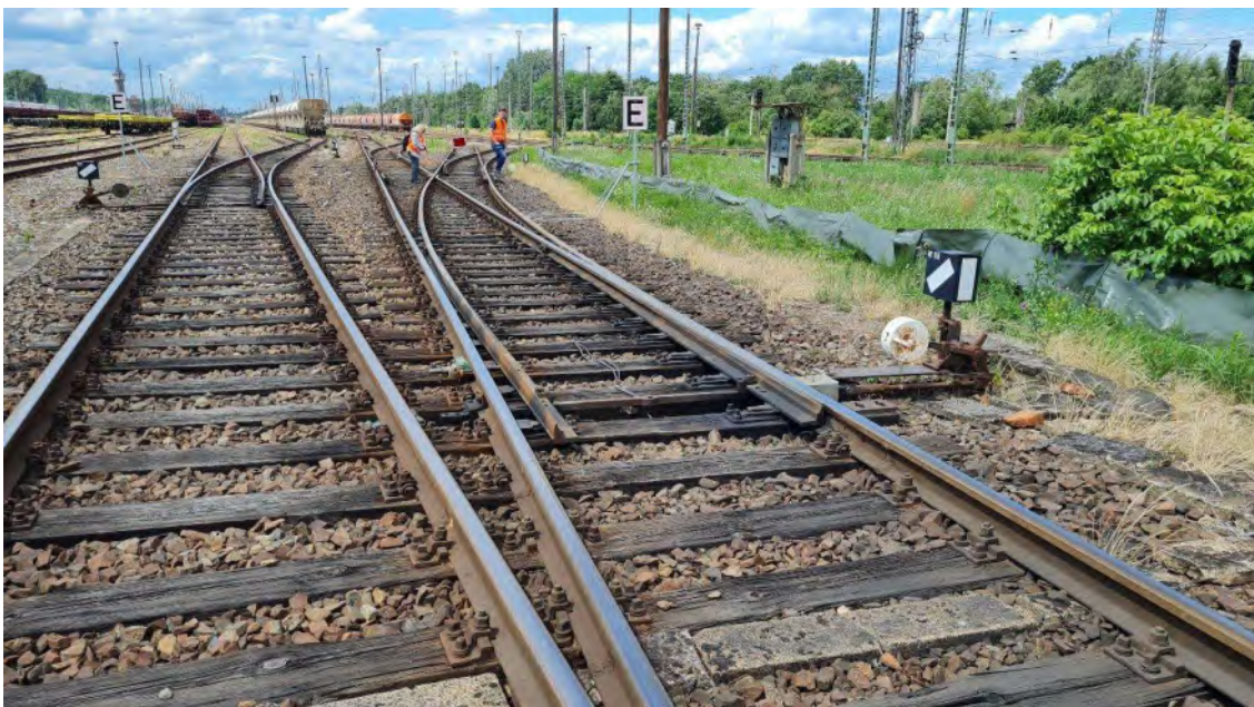
Abb. 6: Endteil Weiche 91 (links Verb. zu W111, rechts W110) – Blickrichtung Westen
