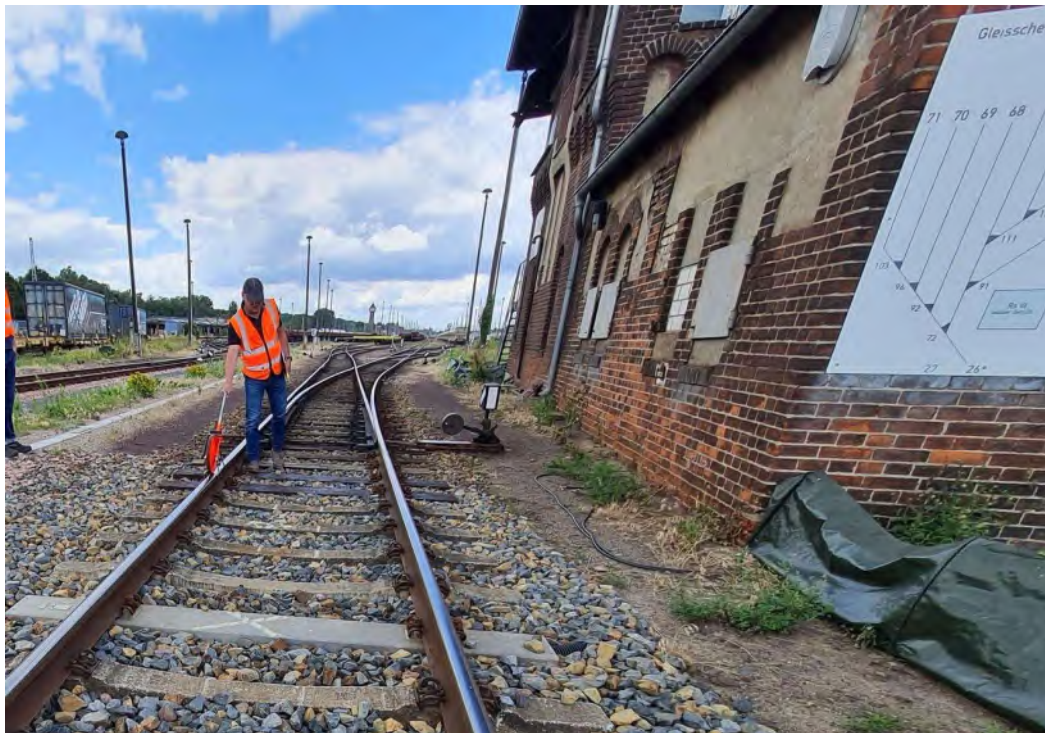
Abb. 3: Weiche 72 (zukünftig Weiche 90) – Blickrichtung Westen, am RS III
